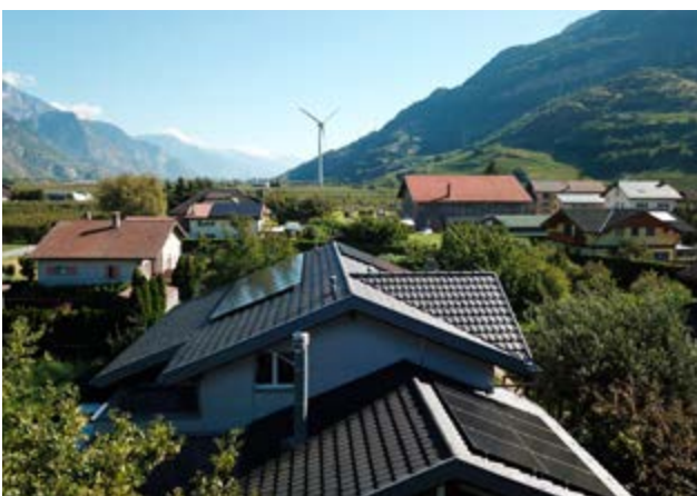
Sinergy ajoute de nouvelles prestations photovoltaïques à son catalogue, comme ici la valorisation d'une toiture à Charrat.
